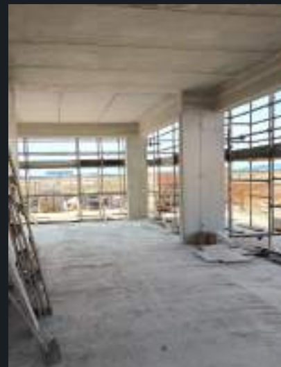
Foto avanzamento cantiere
