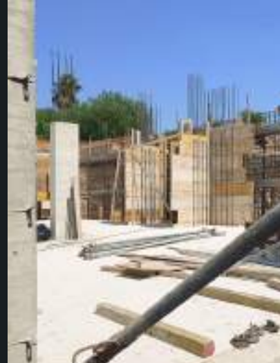
Foto avanzamento cantiere
